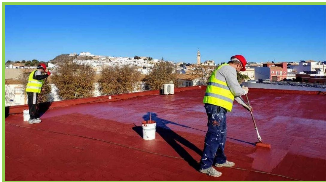
Cobertura impermeable en azoteas. Fuente: lebrija.es
