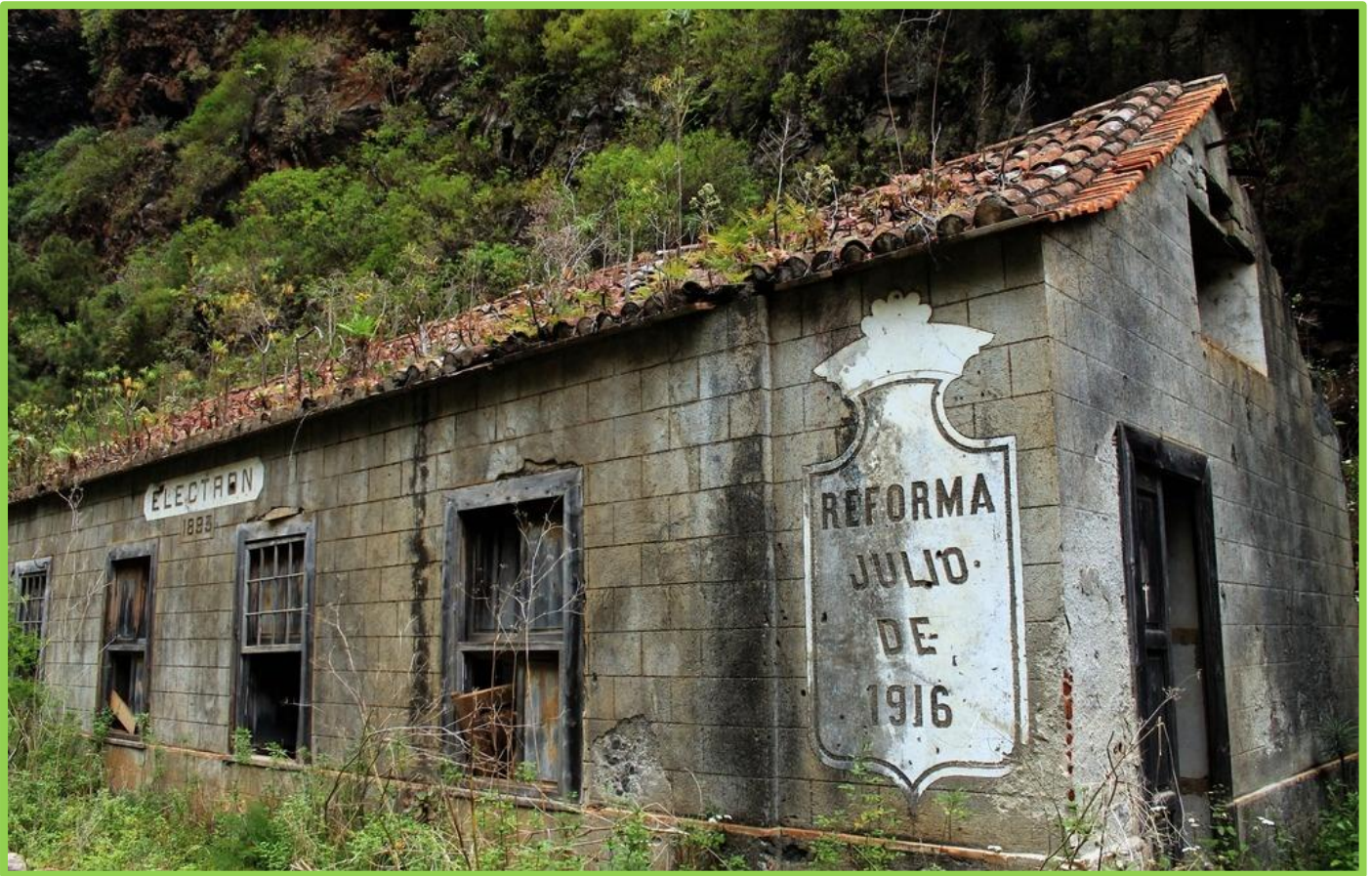
Central hidroeléctrica de El Electrón, 2012.
